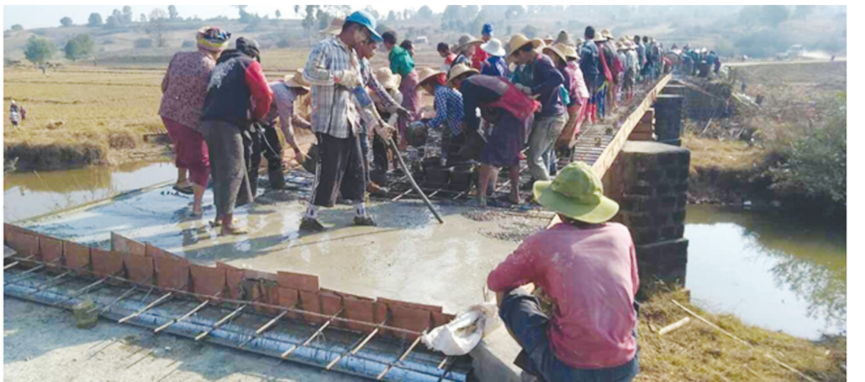
ကလေးမြို့နယ် သာမိုင်းစမ်းကျေးရွာ ကွန်ကရစ်တံတားသစ်ဆောက်လုပ်
