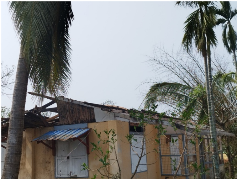
ခရိုင်မှူးနေအိမ် (၃၀'x၂၅')(ခေါင်မိုးအကုန်ကွာကျ၊ တံခါးပေါက်များပျက်စီး)
