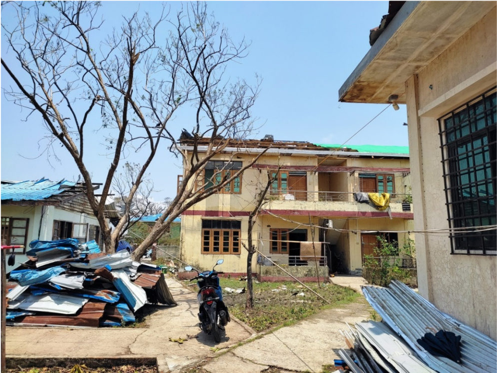
ဝန်ထမ်း(၂)ခန်းတွဲ(၂)ထပ်(၆၀'x၃၀')(ခေါင်မိုးအကုန်ကွာကျ၊ မှန်ကွဲ၊ တံခါး ပျက်စီး)
